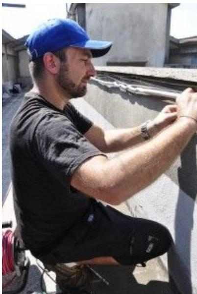
Una volta connesso il cavo all' apparato effettuiamo in corrispondenza dell' apparato il "gomito" e caliamo la guaina contenente il cavo ftp lungo il palo ancorandola con le fascette alternate a del nastro isolante (30cm nastro 30cm fascetta) fino a giungere alla scatola dove vi entreremo dal giunto prima fissato e chiudiamo il giunto avvitandolo sulla guaina.
