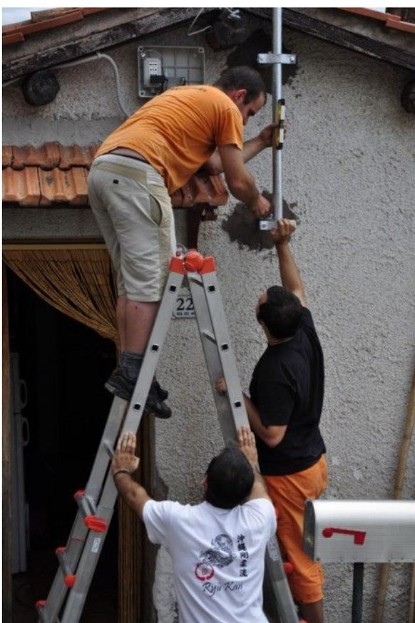
Abbiamo scelto in fase di sopralluogo il punto in cui installare il nostro nodo, quindi si provvederà a forare il muro per il successivo montaggio delle staffe che supporteranno il palo che alloggerà i device.
