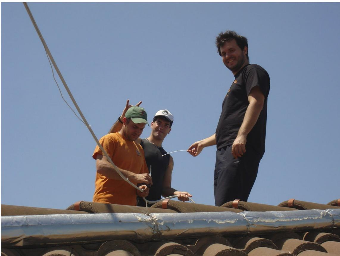
Per misurare la lunghezza del cavo FTP 5E necessario tra scatola ed apparati prendiamo la stessa misura della guaina lasciando una ricchezza di cavo di almeno 20 cm abbondanti dalla guaina da 10 mm ed iniziamo a passarvi dentro il cavo FTP.
